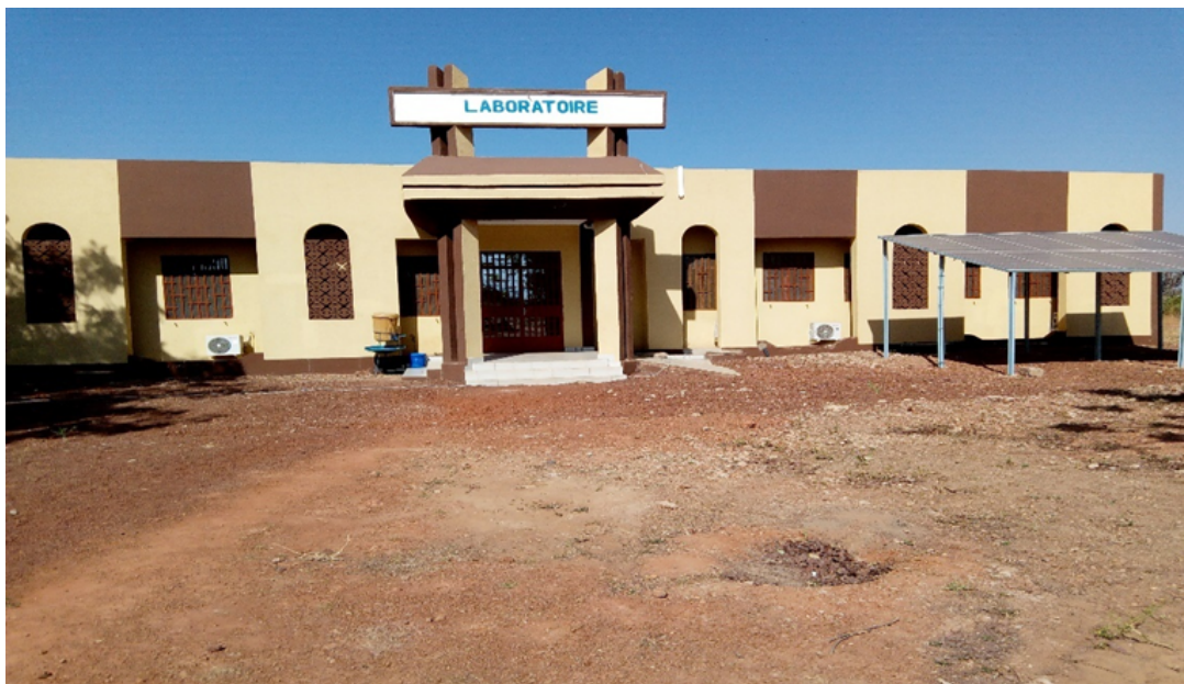
Photo 2 : Bâtiment fonctionnel du laboratoire (10/12/2018)
