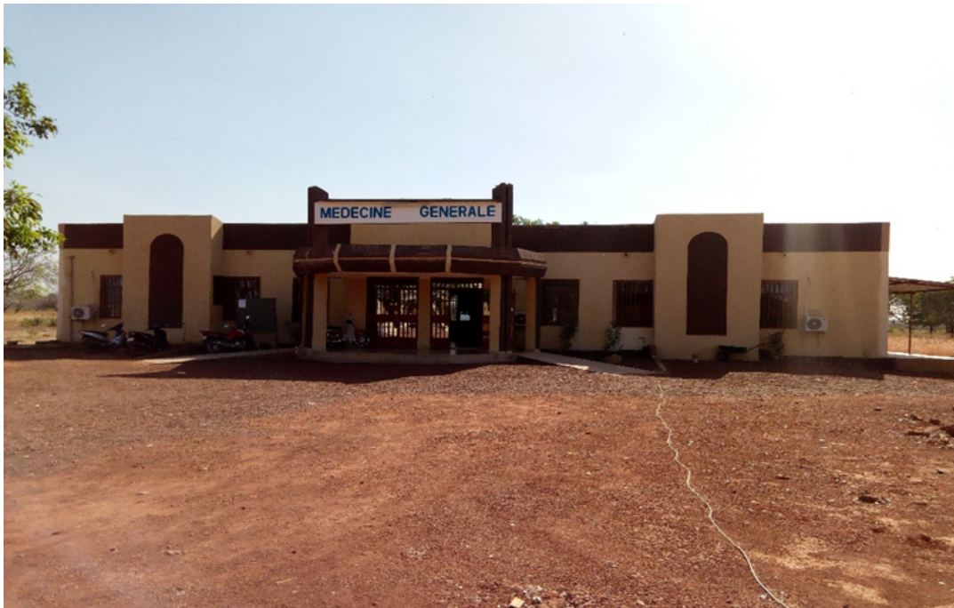
Photo 1 : Bâtiment fonctionnel de la médecine générale (10/12/2018)
